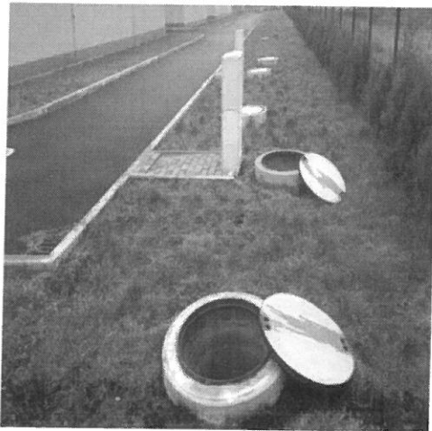
5. Studzienki kontrolno-pomiarowe
