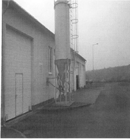
9. Budynek technologiczny oczyszczalni
